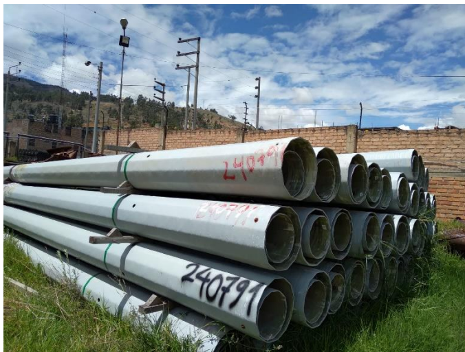
Figura 4. Almacenamiento de postes de acero
